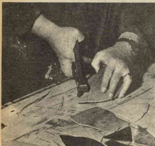
Fig. 4 - Con una tenaglia si sagomano le pietre o l'altro materiale predisposto per il mosaico.
