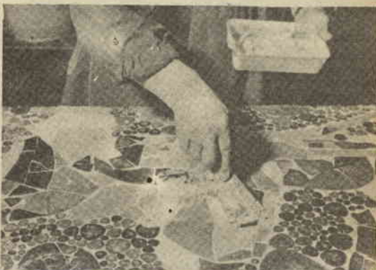
Fig. 6 - I vuoti tra le pietre si riempiono con smalto o calce o calcestruzzo.
