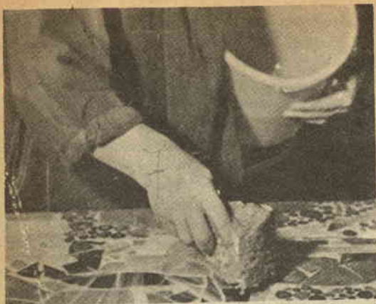
Fig. 7 - Infine si preme con cura il calcestruzzo, finché è ancora molle, mediante una spugna umida.
